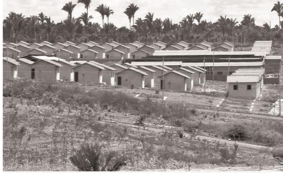
Desvio de finalidade de residências também pode ser verificado no maior conjunto habitacional do Estado, construído com recursos do Governo Federal, casas chegam a custar até R$ 12 mil
